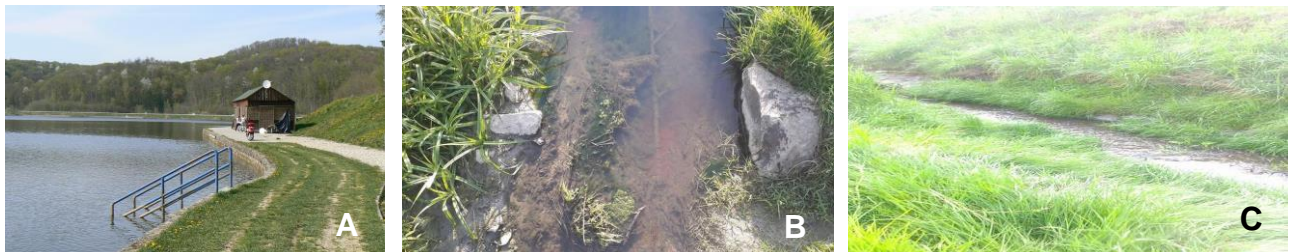
Slika 2. Prikaz mjernih postaja; A - Akumulacijsko jezero Javorica; B - Potok Javorica 2; C - Potok Javorica 1
